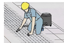
3. ทำความสะอาดฝุ่นที่เจาะ ด้วยเครื่องดูดฝุ่นหรือแปรง
